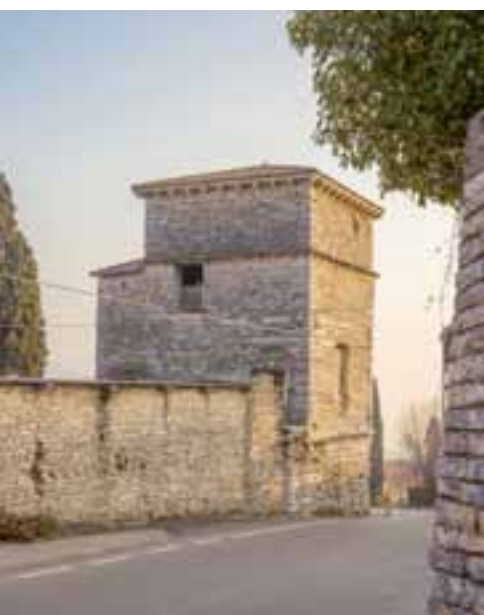
Torre Colombaia nella località di Prun
