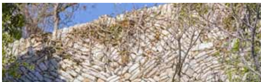
Particolare di muretto "a secco" (marogna)
